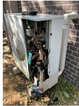
冷却水循環装置の修理
